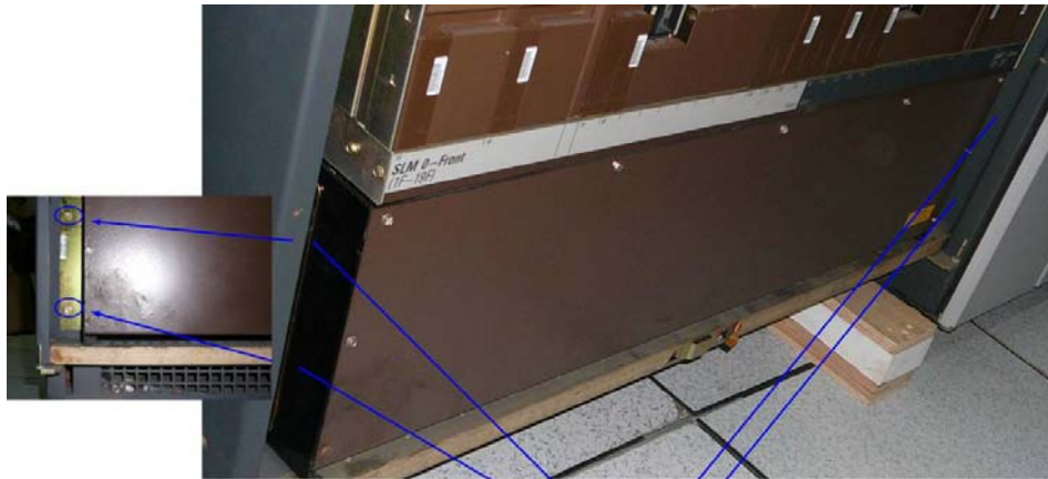
两边共有4颗螺栓，用专用套筒或一字螺丝刀将其卸下。
